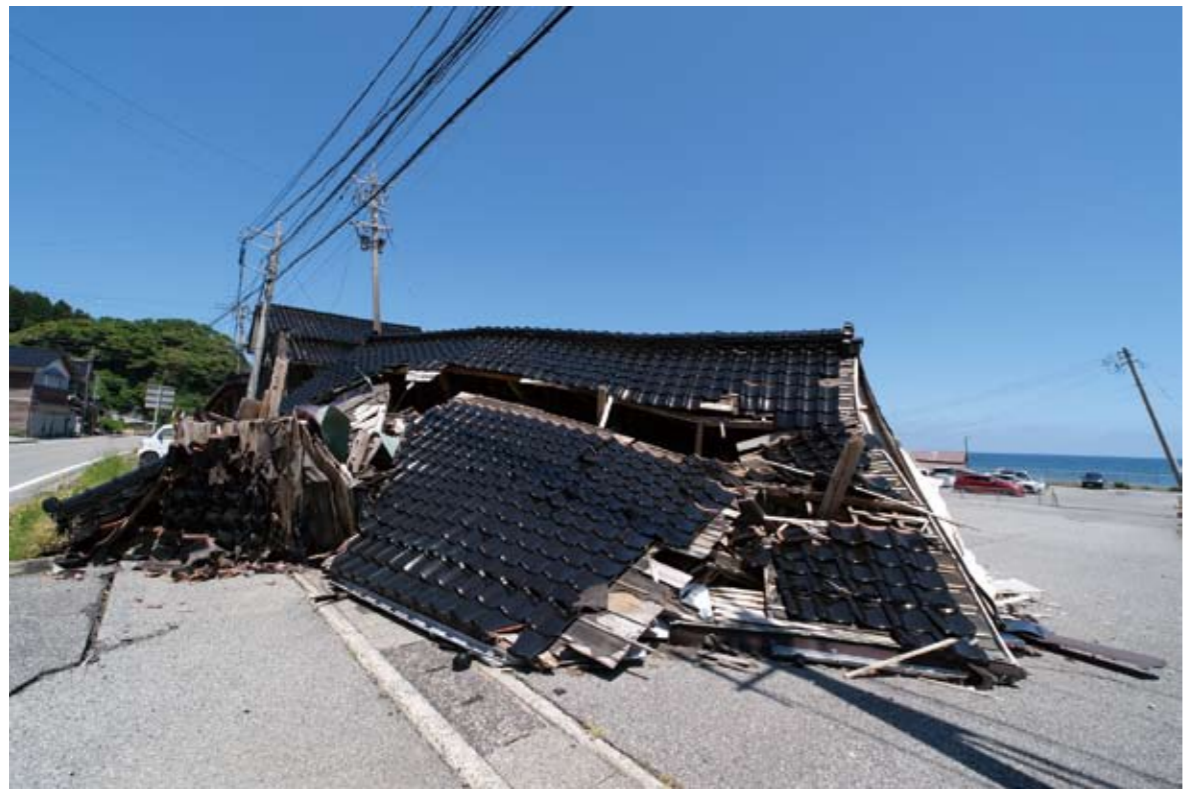
倒壊した能登瓦の家屋
