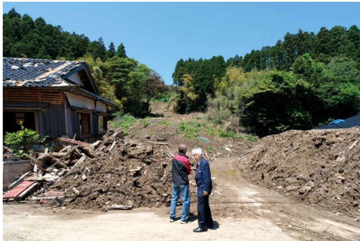
山の斜面が崩れ落ちた場所(珠洲市大谷町)
