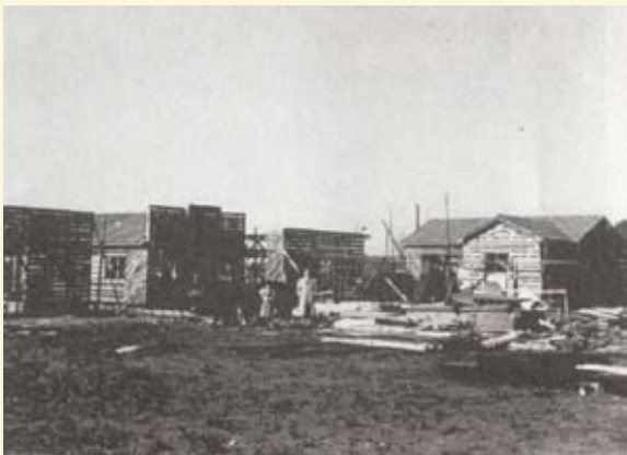
建設中の松波校舎
